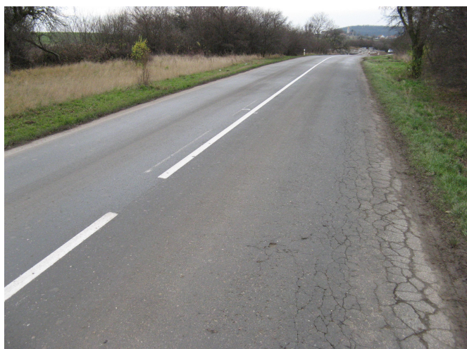
F23, km 27,100 síťové trhliny a plošné deformace
