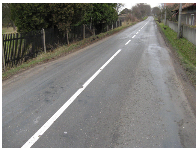
F05, km 25,300 síťové trhliny a plošné deformace po obou stranách vozovky
