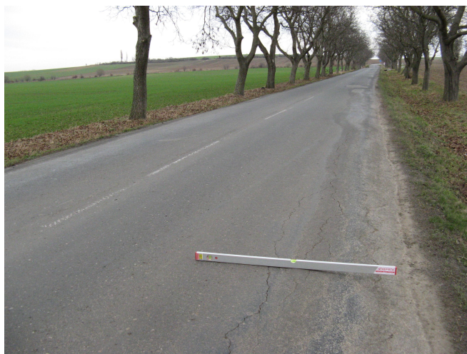
F16, km 26,300 síťové trhliny a plošné deformace
