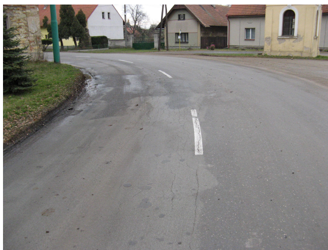
F30, km 27,990 síťové trhliny a plošné deformace v zatáčce
