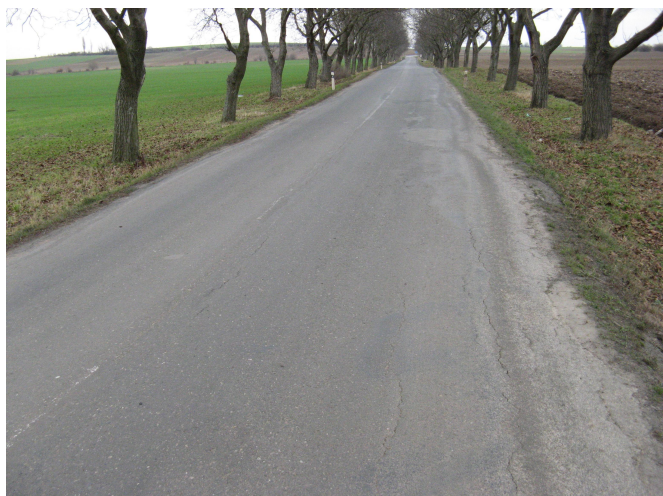
F14, km 26,210 síťové trhliny a plošné deformace
