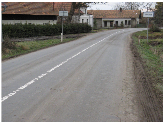
F27, km 27,110 síťové trhliny a plošné deformace před začátkem obce Sovenice.
