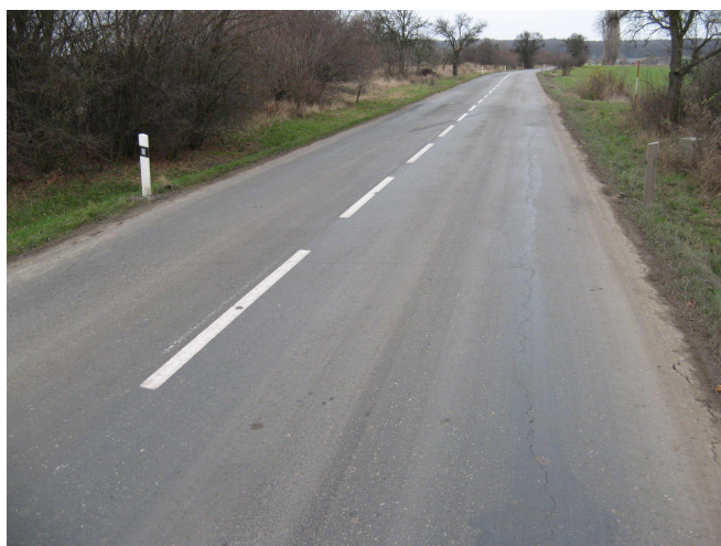
F24, km 27,110 síťové trhliny a plošné deformace
